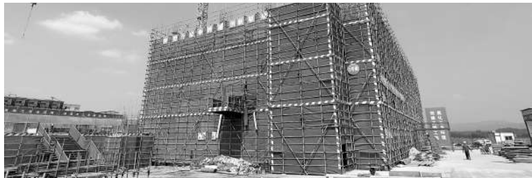
建设中的中科院成都科研中心
